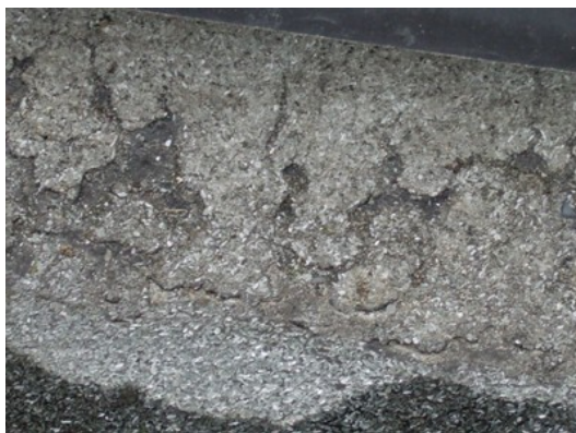
Foto 4 Gebrek: craquelé, gevorderd stadium, omvang 75%
